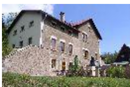
Pohled na budovu RZ
